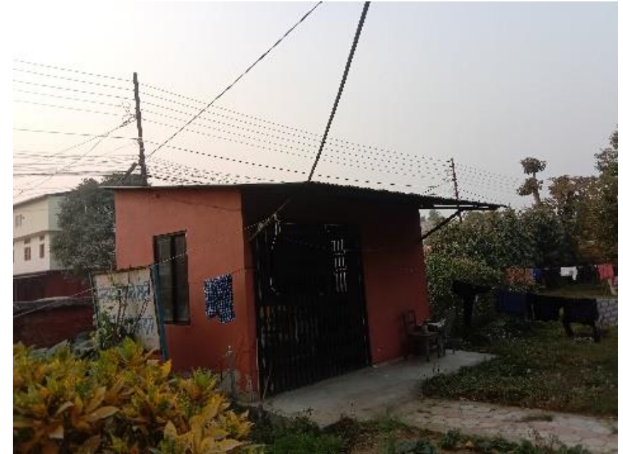
Fig: STORE ROOM
